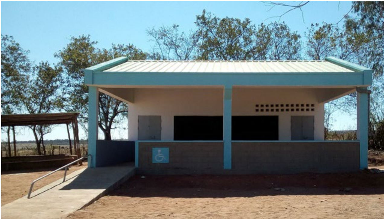
© OIT | Bâtiment scolaire construit par le projet « HIMO Bâtiments » de l'OIT accessibles à des personnes à mobilité réduite
